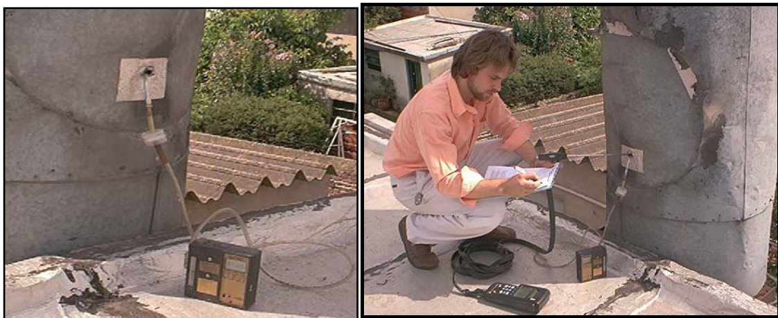
MEDICIÓN DE CONDUCTOS DE EVACUACIÓN
